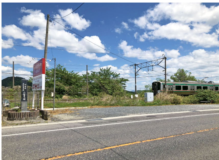
▲すぐ隣には、磐越西線の線路がある
